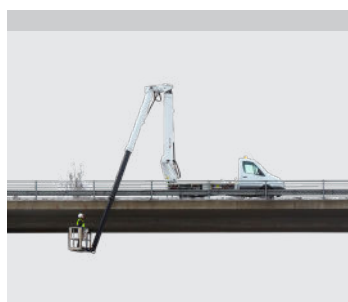
Mulighed for arbejde i et niveau under køretøjet (-3,3 meter)
